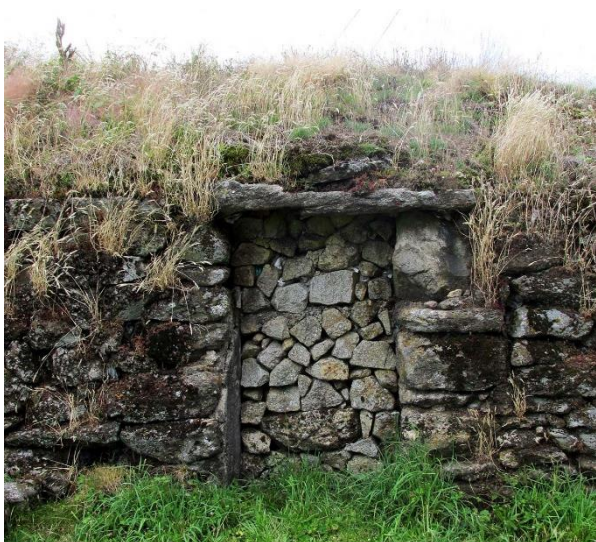
Fig. 33: Forno de Queimadelo (exterior)
