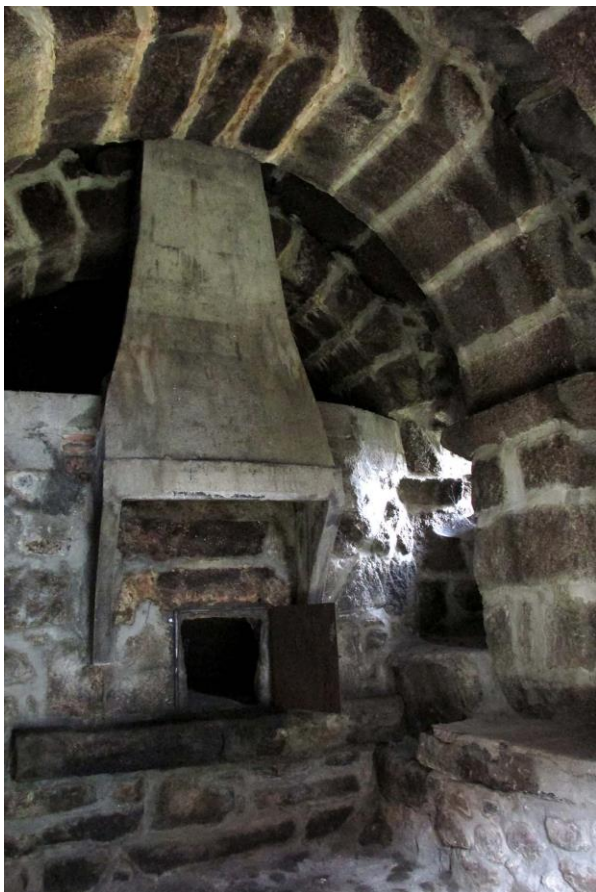
Fig. 30: Forno de Várzea Travessa (interior)
