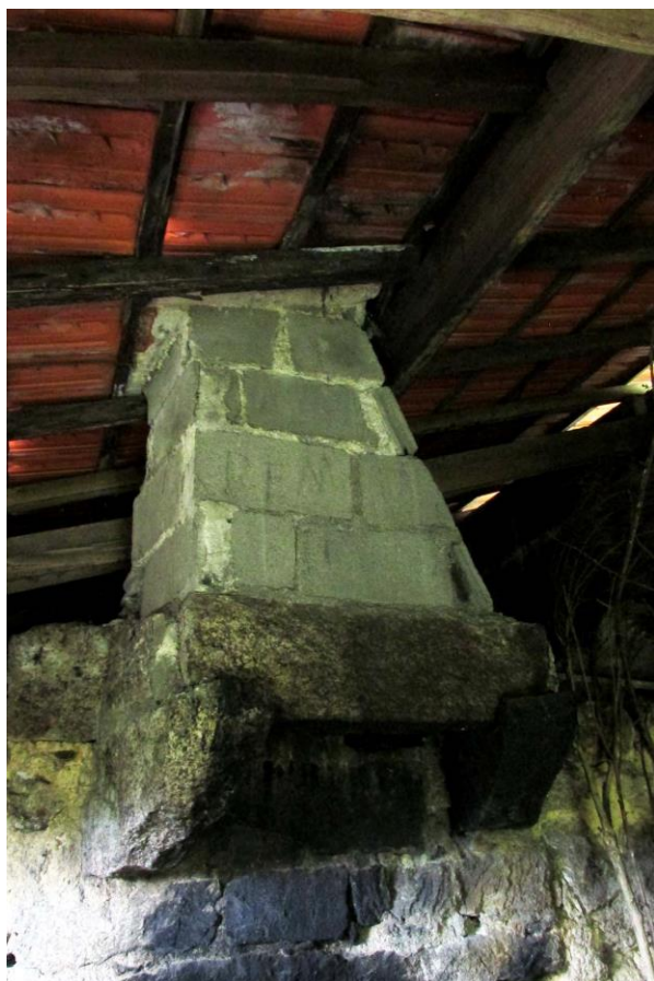
Fig. 25: Forno da Podre Chaminé (interior)
